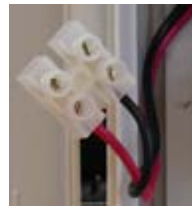
Рисунок 12. Клеммы для подключения замка к блоку питания
