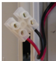
Рисунок 10. Клеммы для подключения замка к блоку питания
